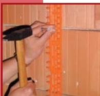
Befestigung der VarioSchiene 16/100 (SWH2)
