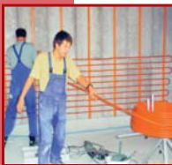
Varioklima-Rohr ruckzuck verlegt
