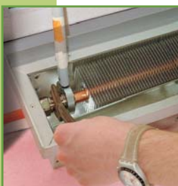
Anschließen an die Leitung
