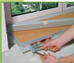
Mit Stellschrauben waagrecht einrichten
