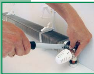
Anschließen an Vor- und Rücklauf
