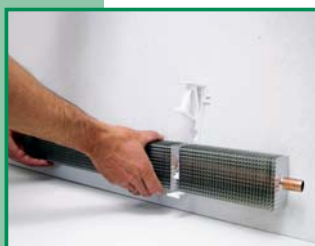
Einlegen des Heizelementes
