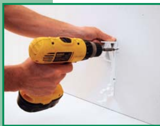
Befestigung der Halter
