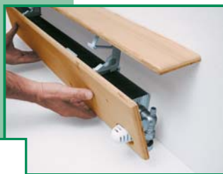
Anbringen der bauseitigen Verkleidung
