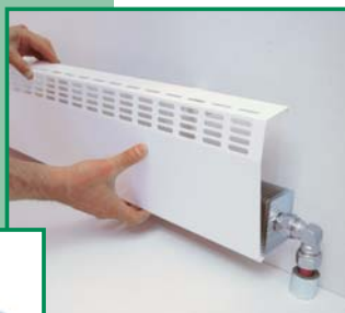
Einhängen der Delta-Verkleidung
